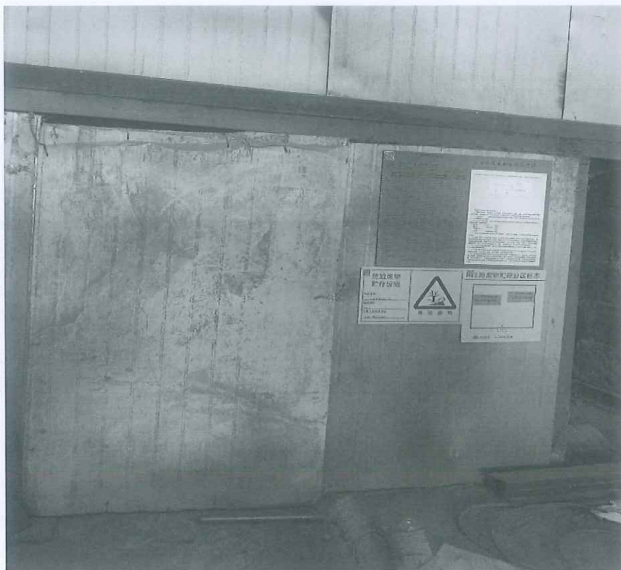
图 4.3 危废贮存仓外部图
