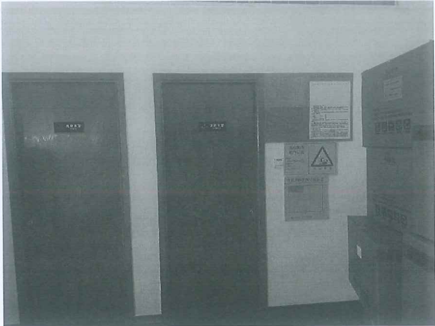
图 4.3 危废贮存仓外部图
