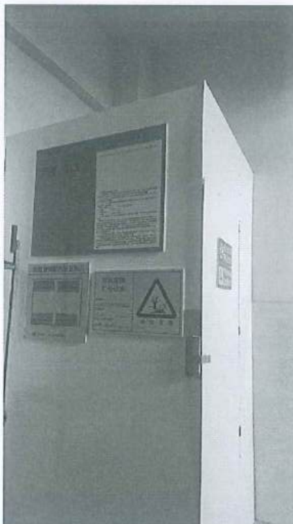
图4.2危废间外部图
