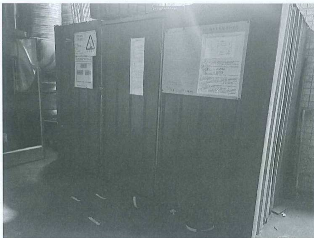
图 4.3 危废贮存仓外部图
