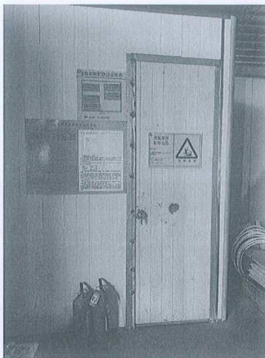
图 4.2 危废间外部图
