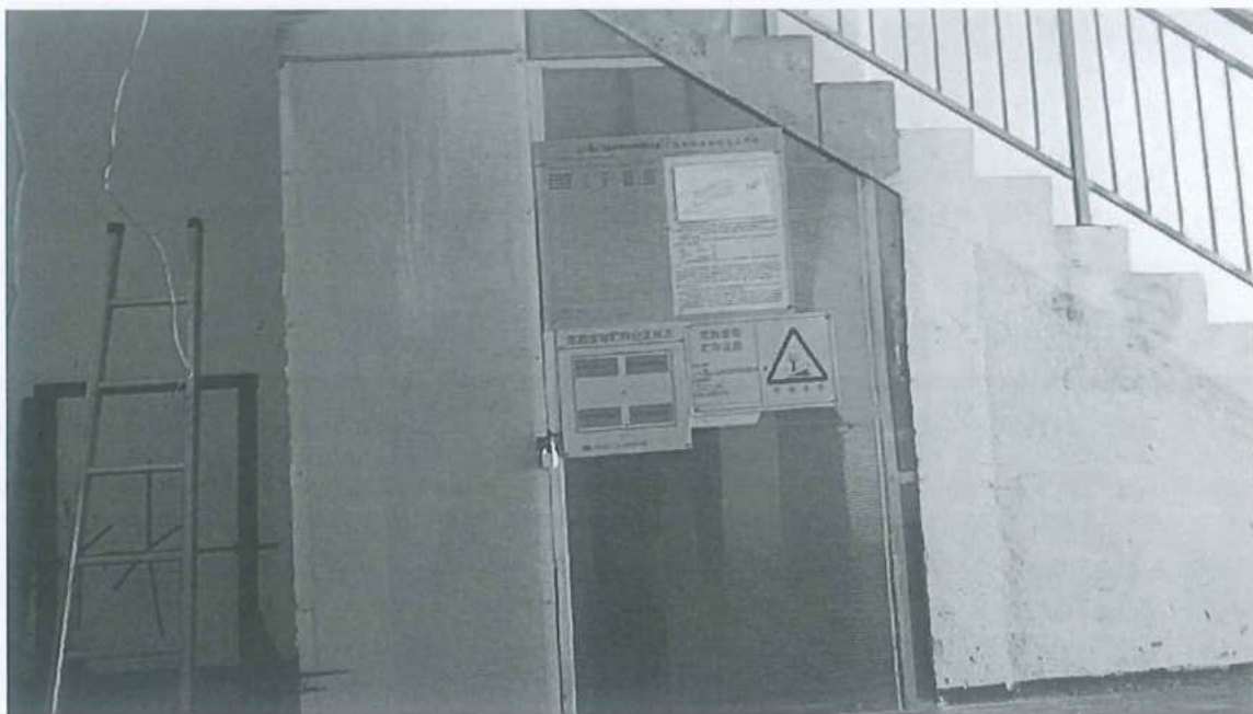
图 4-4 危废贮存仓外部图
