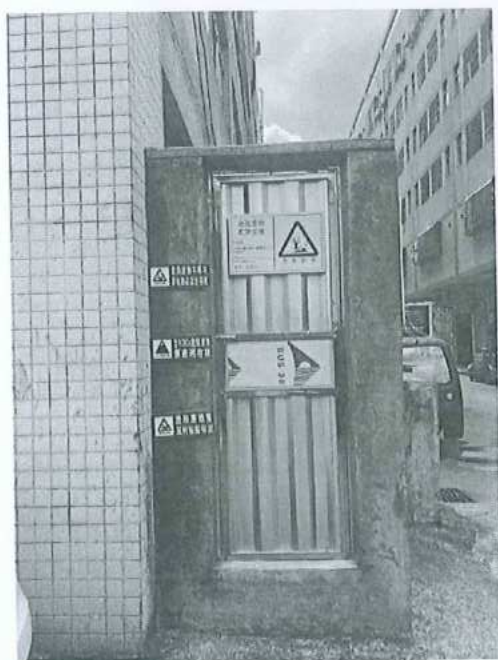
图4.2危废间外部图
