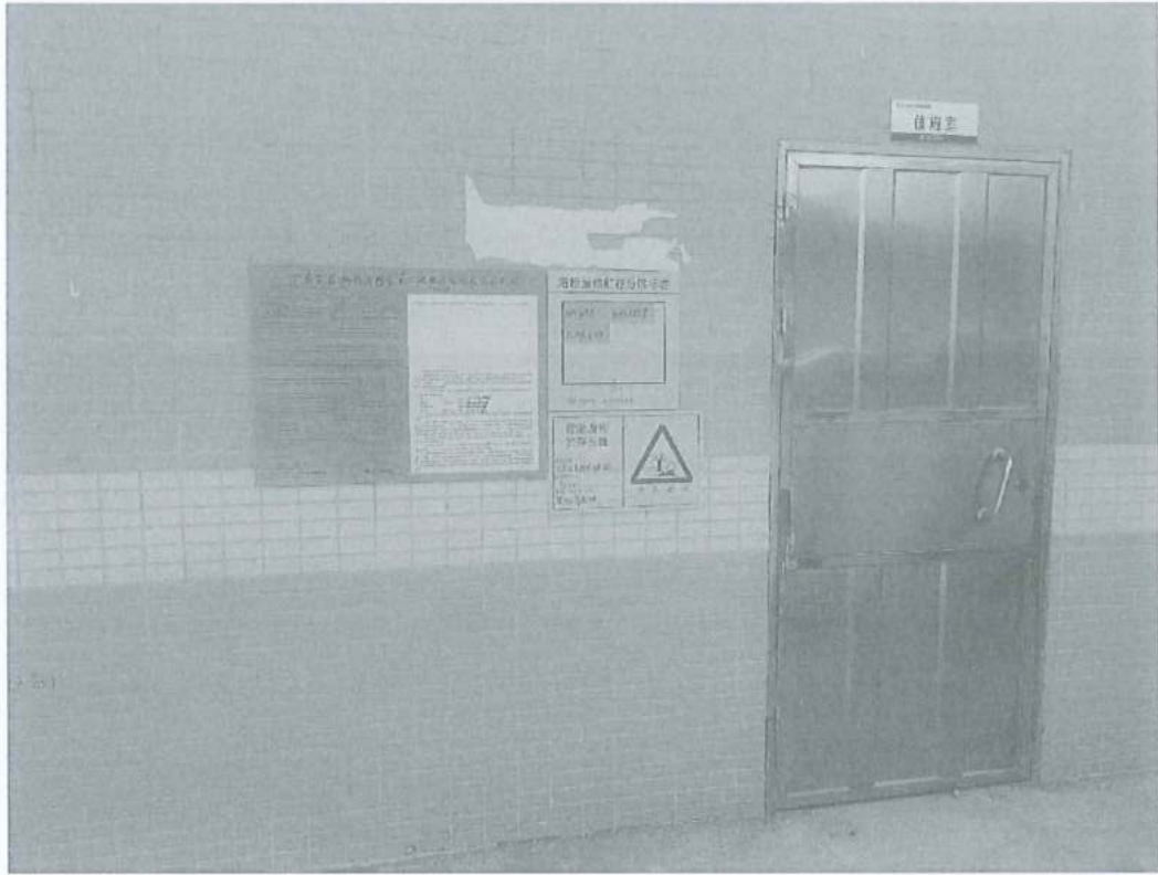
图 4.4 危废贮存仓外部图
