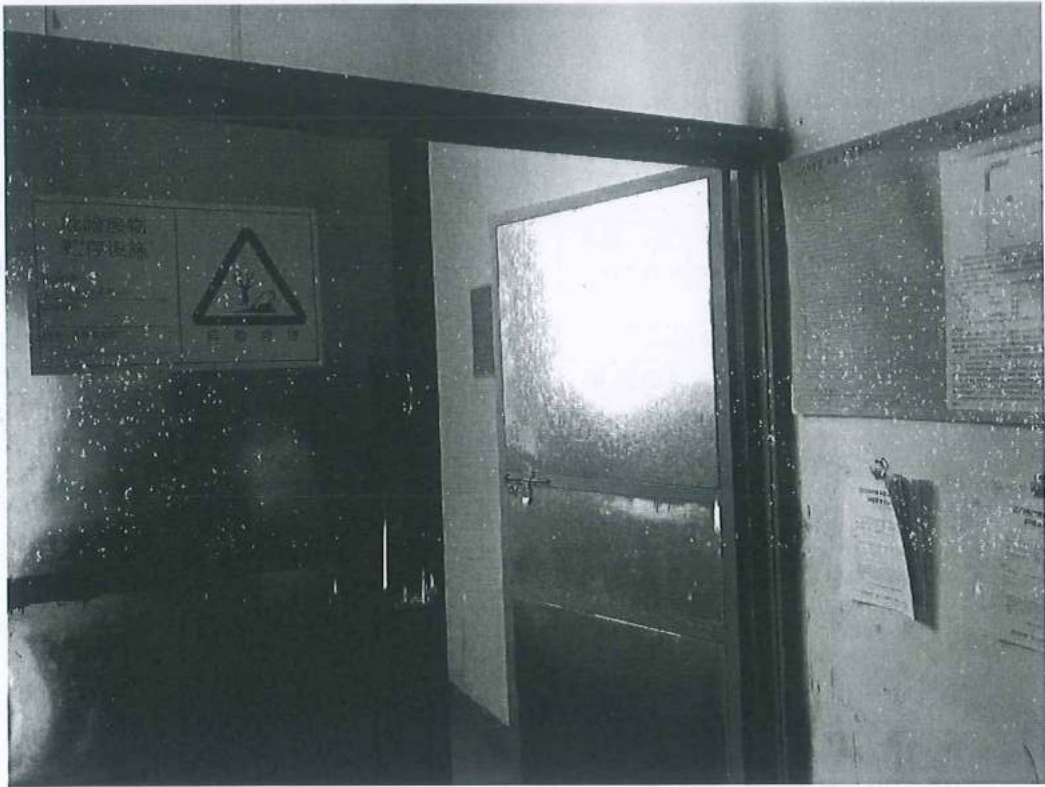
图 4.3 危废贮存仓外部图
